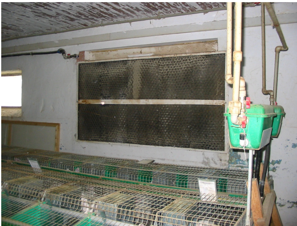
33. kép: Falba épített hűtőpanel nyúltelepen
