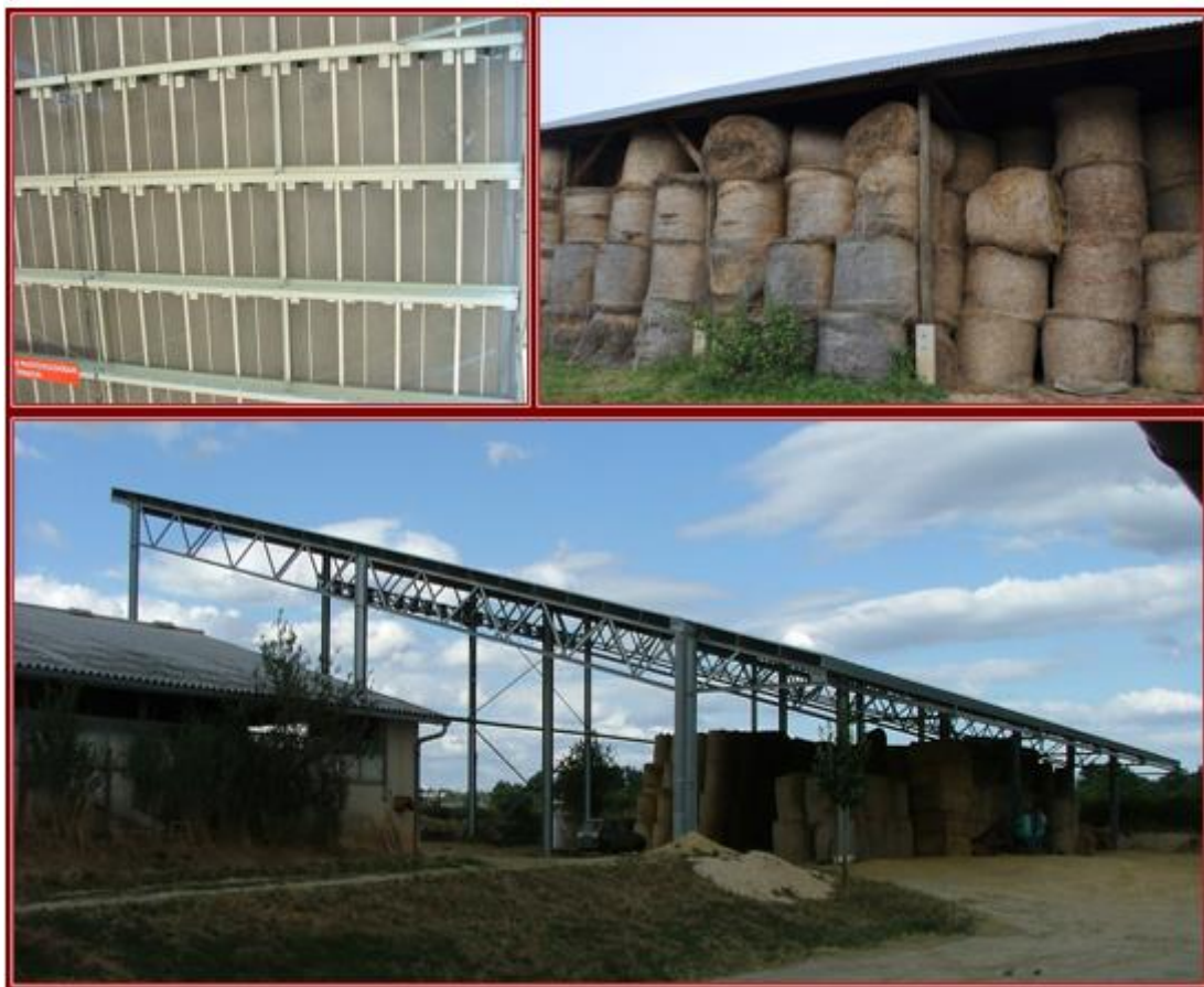
53. kép: Vasvázas szénatároló napelemekkel
